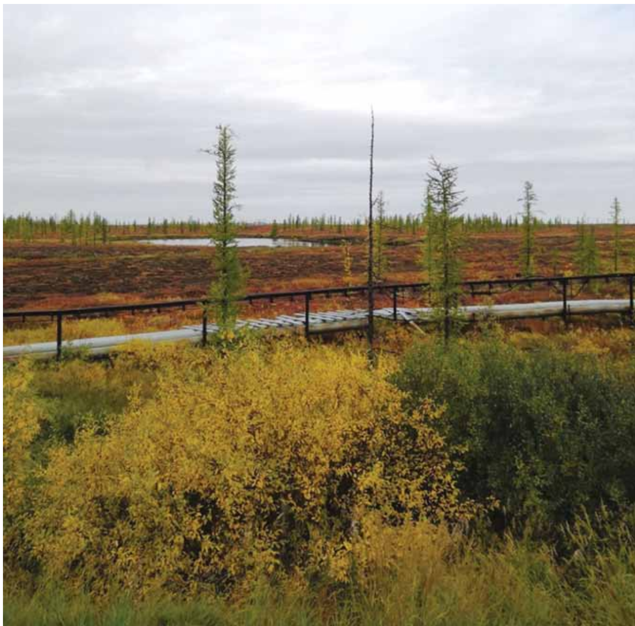
Рис. 1. Прокладка газовой трубы над долиной малого водотока. На заднем плане термокарстовое озеро Fig. 1. Laying a gas pipe over the valley of a small watercourse. In the background is thermokarst lake
