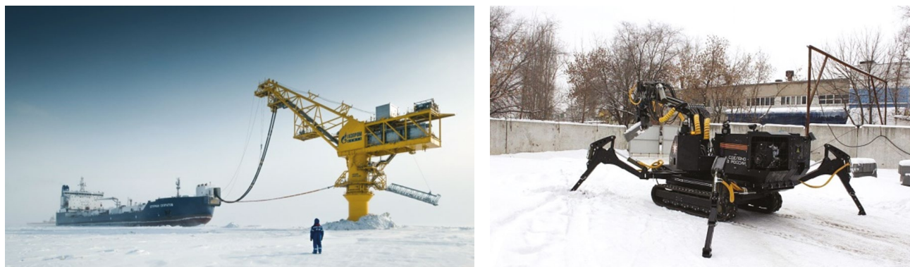
Рис. 2. Нефтеотгрузочный терминал «Ворота Арктики» и робототехнический комплекс «РОИН Р-300»
